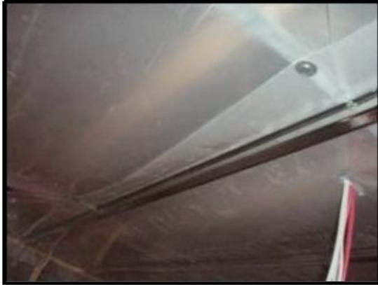
9. *Installer le carton fibre de 7/16" x 6" de large à 2" sous les solives aux murs porteurs et murs extérieurs qui tiendra le polyéthylène du plafond lors du soufflement des plafonds, pose de fourrures 1 x 3 aux pourtours des fenêtres et portes, installer le matelas sur les murs en partant sur le carton fibre en haut, brocher sur les colombages muraux et faire l'installation des barres résilientes pro à 2" sous le carton fibre et le reste à 24" c/c 4 barres sur 8'.*
