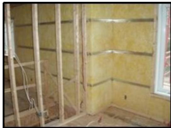
10. *Faire l'installation des gypses 5/8" au plafond perpendiculaire aux fourrures métalliques en pressant le gypse sur le matelas/carton fibre au mur pour sceller acoustiquement les bruits solidiens et aériens pour les deux rangs de gypse, sceller autour des boites électriques pour le 1<sup>er</sup> rang.*
