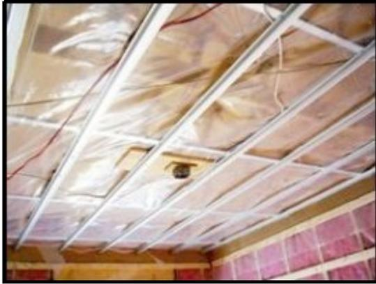
7. Les sorties d'air devront être ancrées à la suspension du plafond et les placer le plus bas possible vers le plafond, visser un gypse 5/8" au-dessus de chaque sortie d'air la largeur entre les solives x 48" de long visser au plancher de base pour diminuer les sons traversant le plancher et souffler un peu plus d'isolant sur ces tuyaux de ventilation.
